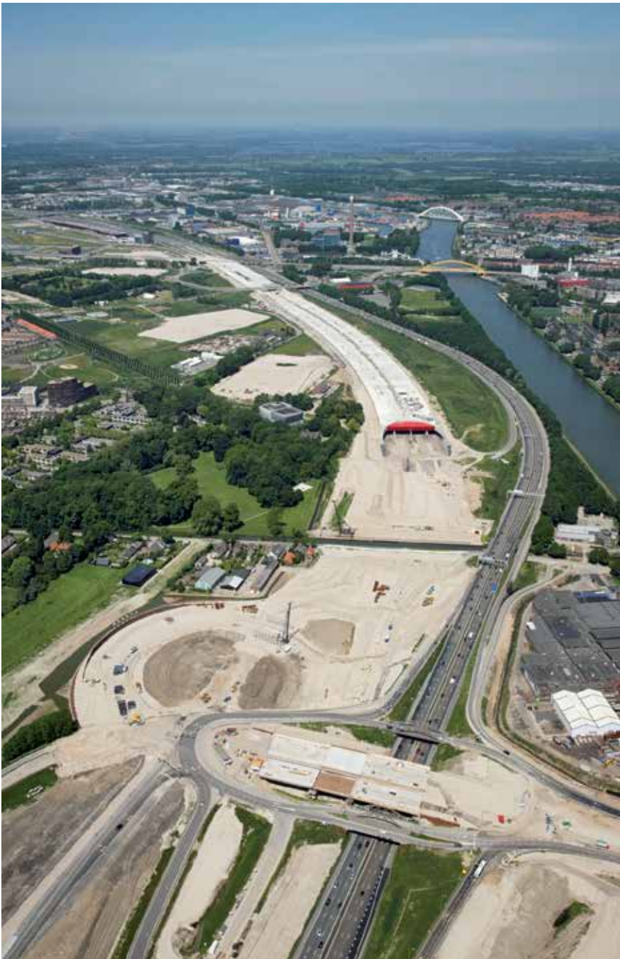
Fig. 1. Aerial photo of the Landtunnel Utrecht. (Gerry Hurkmans, 2009).
