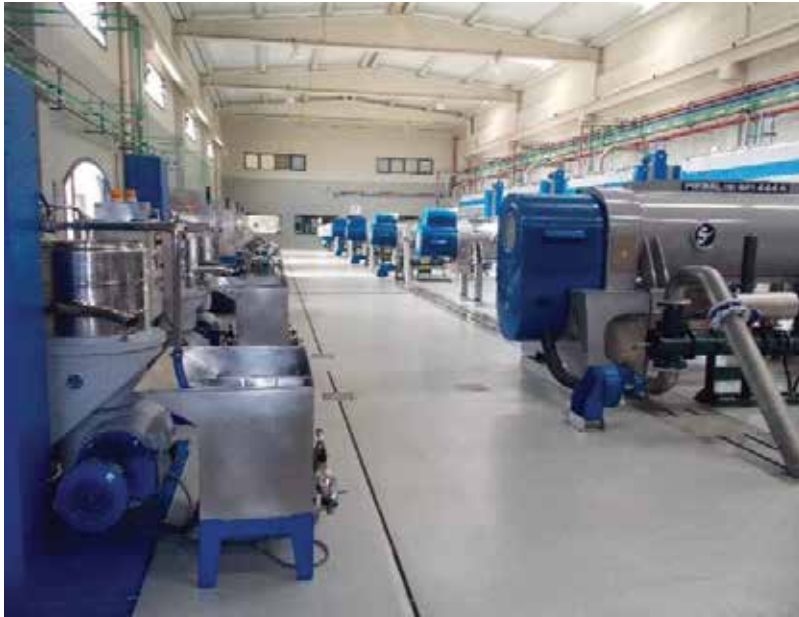
Figure 7. Two-phase decanters in series in an olive mill for the extraction of olive oil (Picualia, Proyecto de traslado y perfeccionamiento de almazaras por fusión de Cooperativas 'Agrícola de Bailén virgen de Zocueca', Jaen, Spain) (Source: Marco Nuti).
