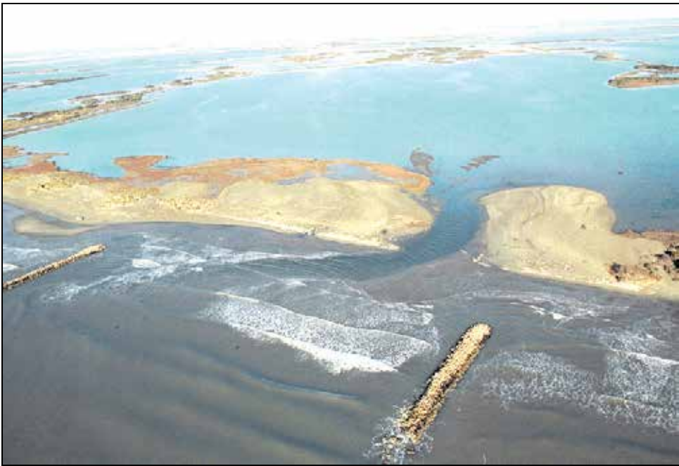
Fig. 7. Sea intrusion due to storm in 1997 (source : EID Méditerranée)
