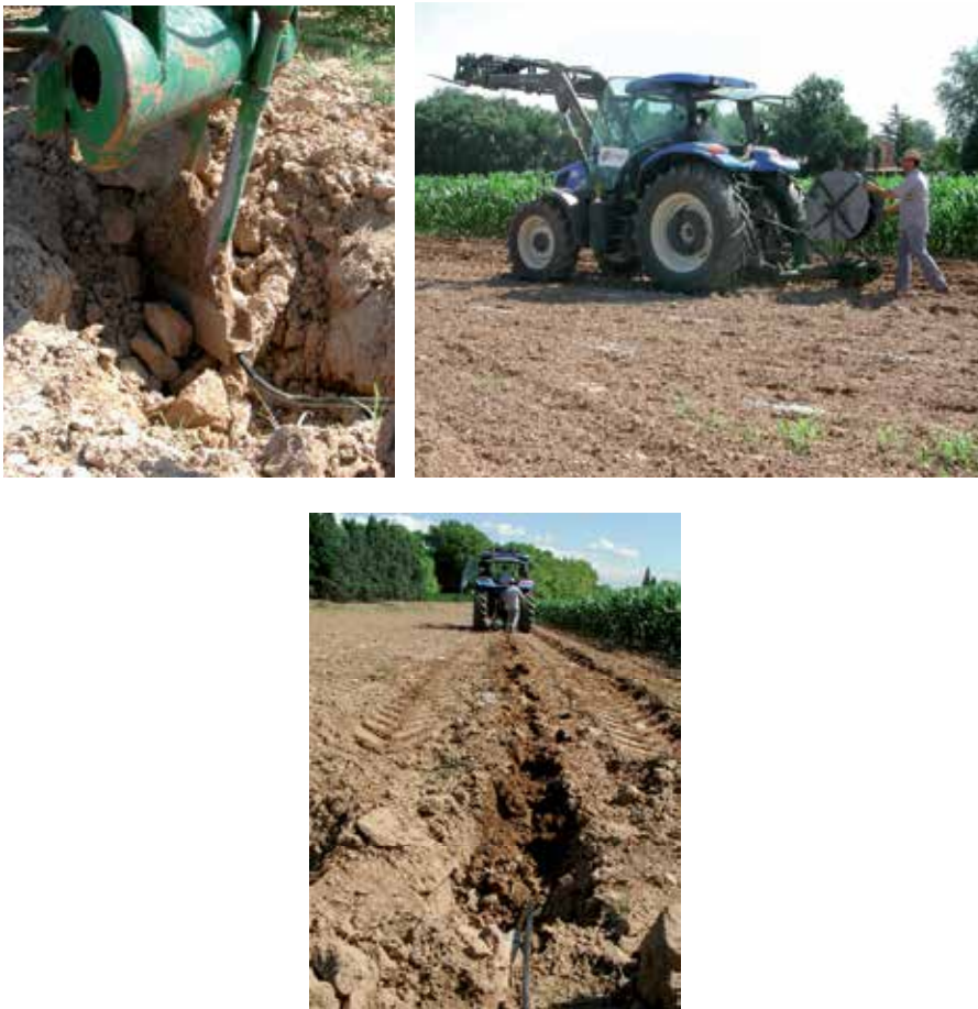
Fig. 4. Installation of SDI.
