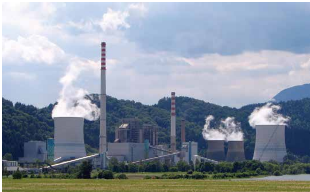
Fig. 8. Thermal power plant Šoštanj
