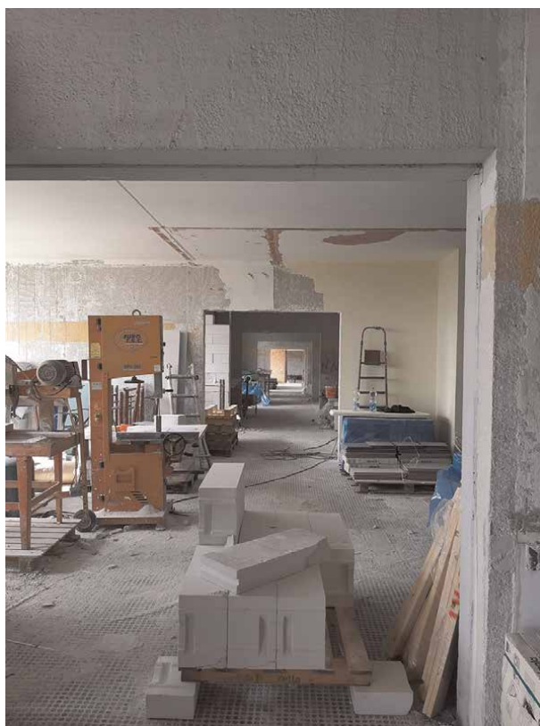
Figure 6. The regeneration, work in progress. Credit: Laboratorio di Città Corviale.
