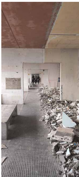
Figure 7. The regeneration, work in progress. Credit: Laboratorio di Città Corviale.
