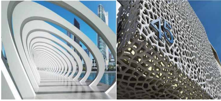
Figure 11. UHPC architectural pours.
