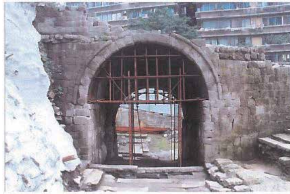
图八：北立面现场照片
